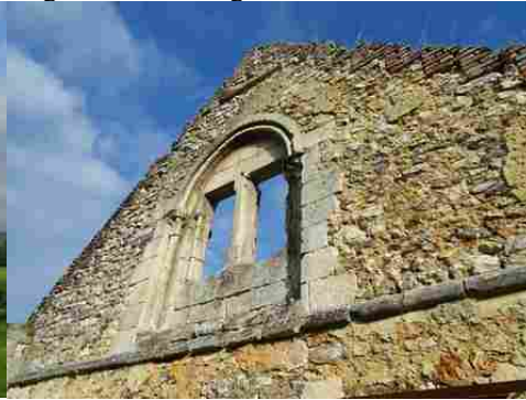
Une baie géminée et ouvragée
