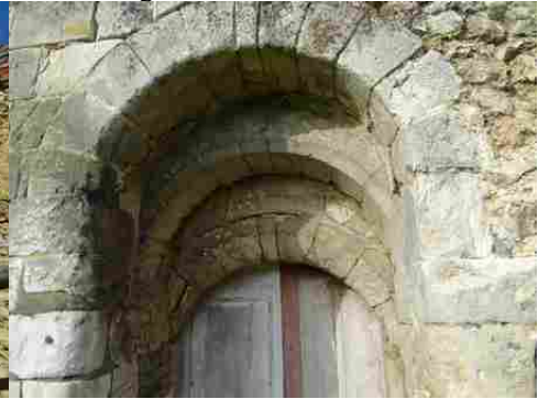
Les arcs de la porte du cellier
