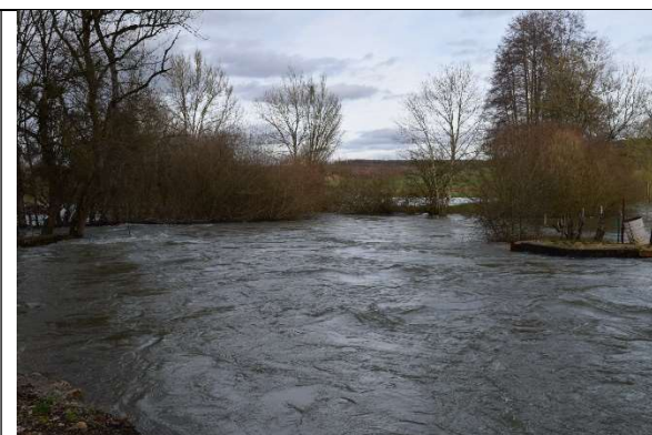
Figure 14. Courant très fort au niveau de l'ancien vannage de Belan sur Ource, effacé en 2017. 24/01/2018
