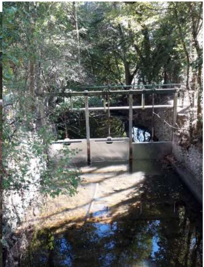
APRES TRAVAUX (Mise en eau non encore effectuée)
