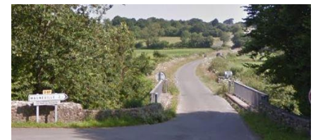
Pont sur la Douve / D87 en venant de Néhou
