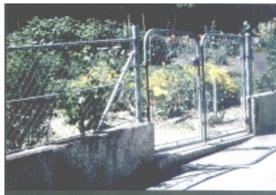
La grille d'entrée
